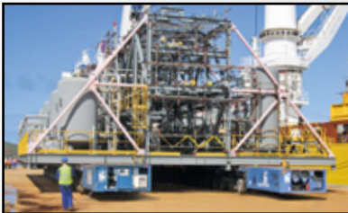
Budownictwo morskie i budowa urządzeń
